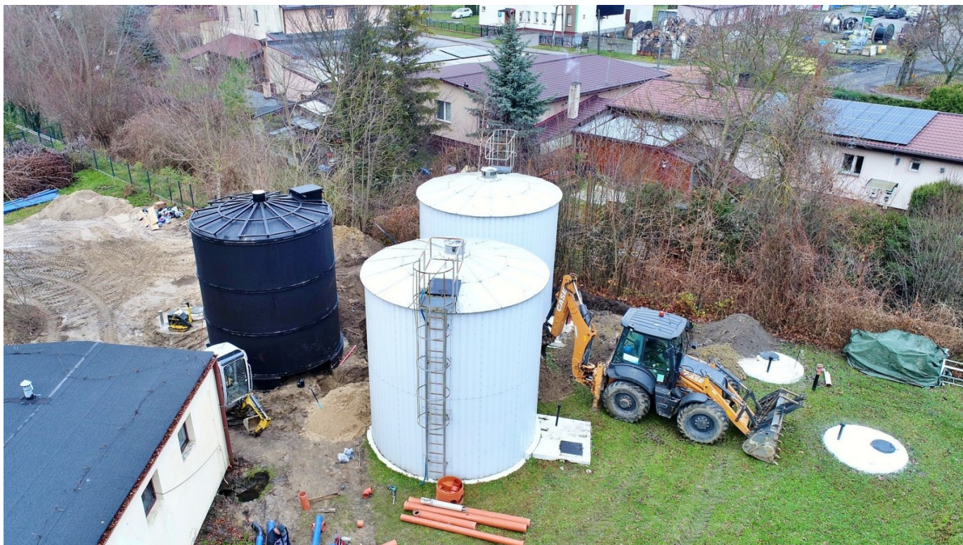
Stacja uzdatniania wody w Bukowcu będzie miała nowy zbiornik retencyjny
